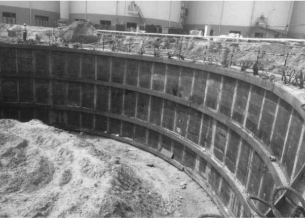
图 1 刚柔复合防渗漏可回收支护体系
