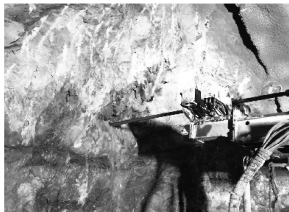
图 7 掌子面进行卸压爆破
