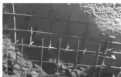
(b) 金属网在超挖处无法紧贴巷道壁面
