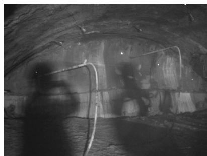
图6 帷幕注浆现场施工
