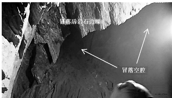
图 2 K400+249 断面掌子面前方冒落
