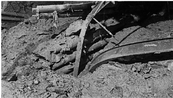
图 11 隧道冒落破坏现场 Fig. 11 Photo of rock falling in tunnel
