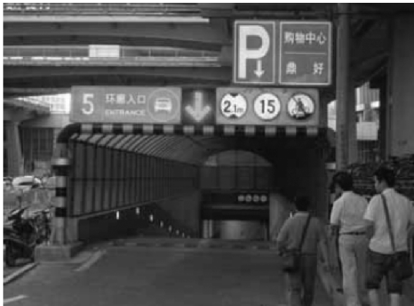
图2 过大纵坡带来的视距不良
