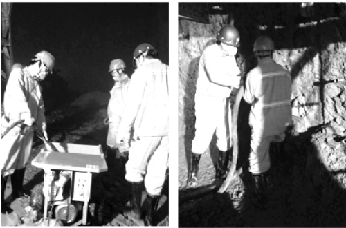
图 26 现场灌浆施工图
