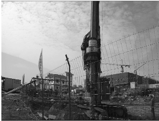
(a) 中联 ZR220 A 旋挖钻进中的施工现场
