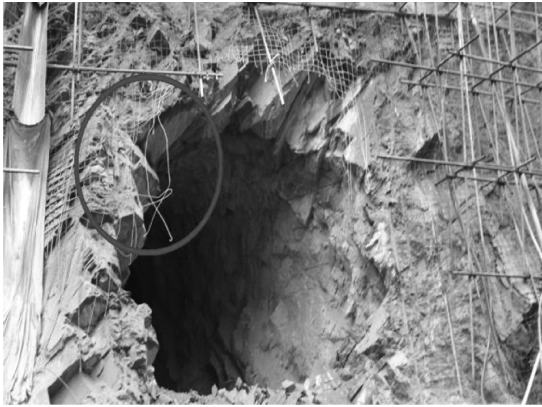
图 1 隧洞入口处的非凸关键块体
