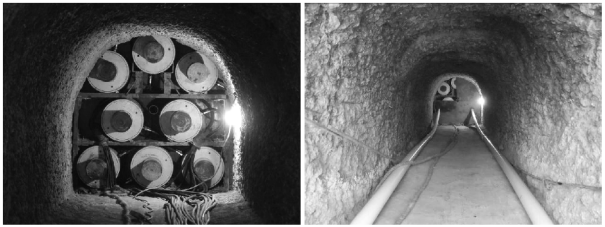
图3 单锚体千斤顶安装照片
